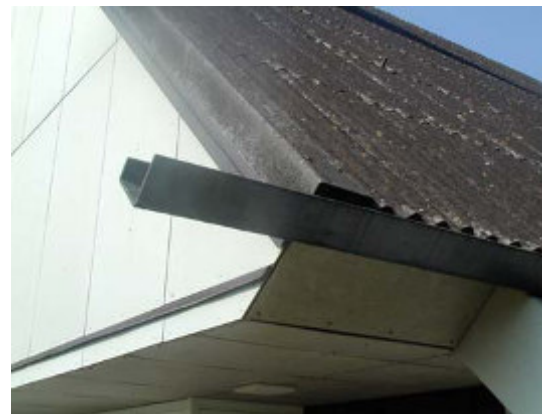
Toiture ondulée en fibrociment
