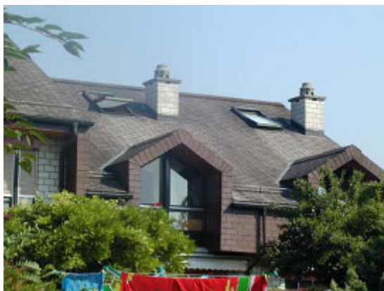
Tuiles en fibrociment
