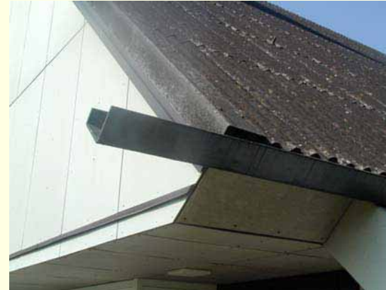
Toiture ondulée en fibrociment
