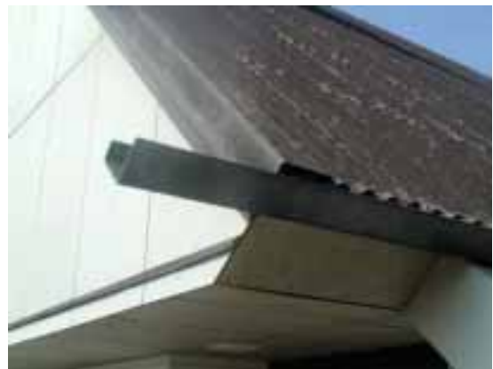
Wellplatten aus Asbestzement
