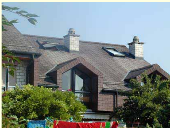
Dachziegel aus Asbestzement
